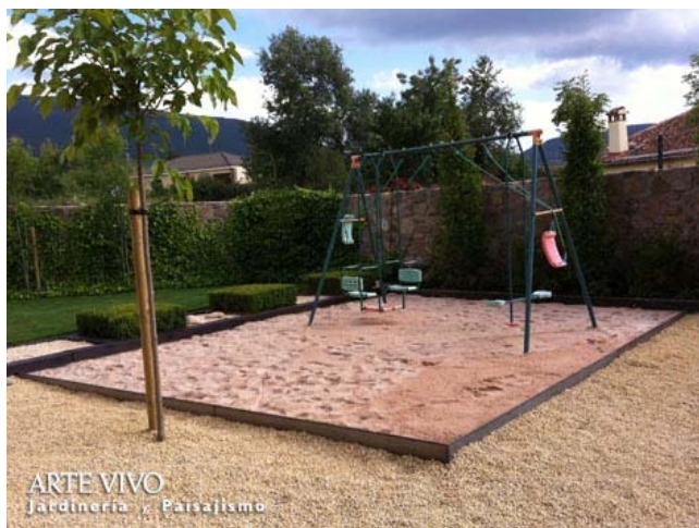
Juegos de niños sobre arenero con bordes de Fleje metálico en zona de jardín pavimentada con gravilla. Santo Tomé del Puerto, Segovia.
