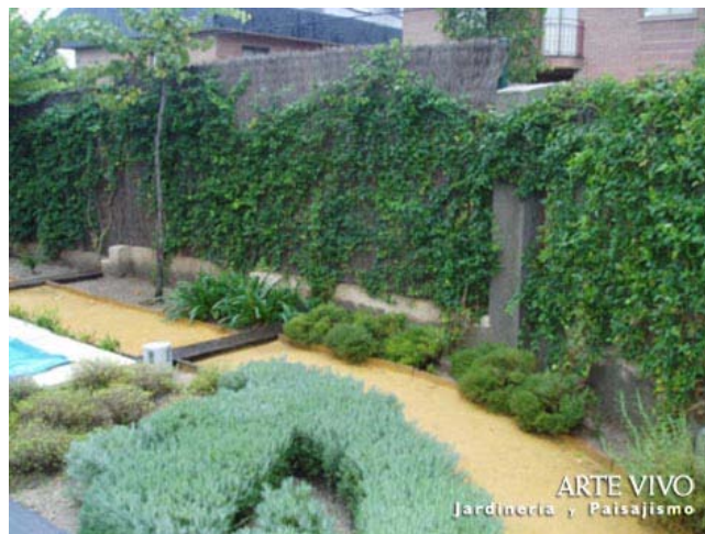
Sendero de Arena de Albero con traviesas de ferrocarril y delimitado con listones de madera entre zonas de plantación.
