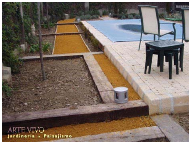
Acceso a solado de piscina salvando distintos niveles con divisiones de traviesa de ferrocarril entre plantaciones y arena de Albero.
