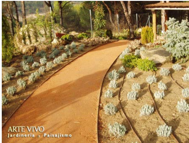
Camino con Zahorra natural bordeado con fleje metálico en jardín de Cebreros, Ávila.
