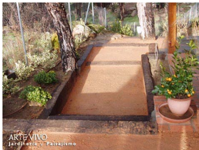
Acceso a cenador con barbacoa de casa de campo en Cebreros, pavimentado con Zahorra natural y con escalones de traviesa de ferrocarril.
