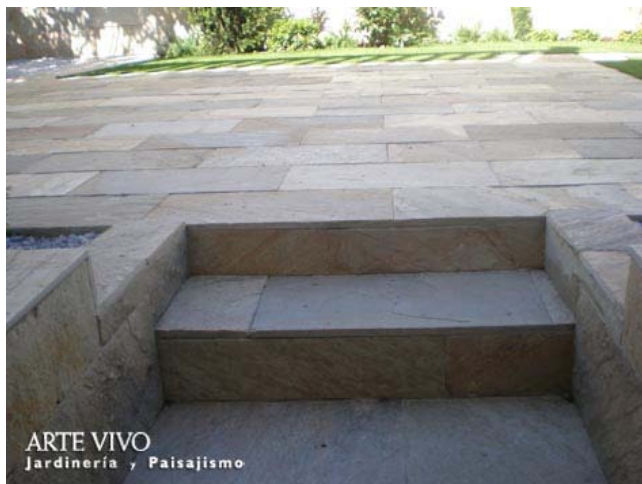
Detalle de escalera de acceso a sótano chapada con Cuarcita Oro regular fijada con mortero de cemento especial para piedra natural en vivienda de Getafe, Madrid.
