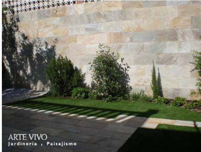
Muro frontal revestido con Piedra natural Cuarcita Oro regular con plantación sobre tierra y gravillas en su base. Perales del Río, Getafe.
