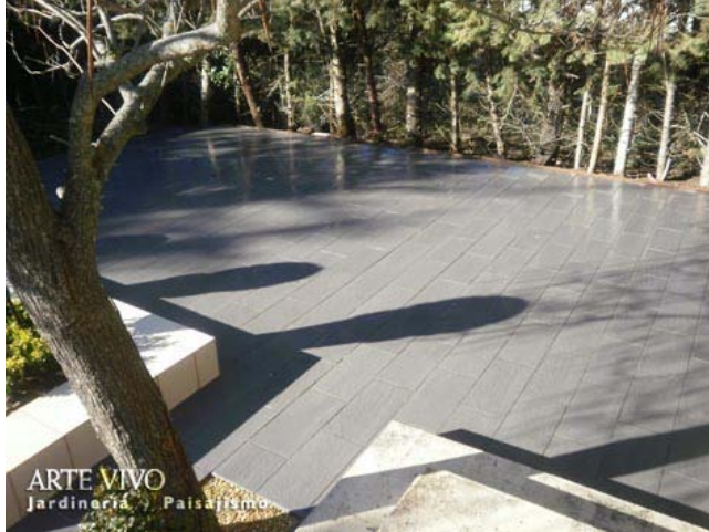
Zona lateral de jardín solada con baldosas de Gres porcelánico color gris en Soto del Real, Madrid.
