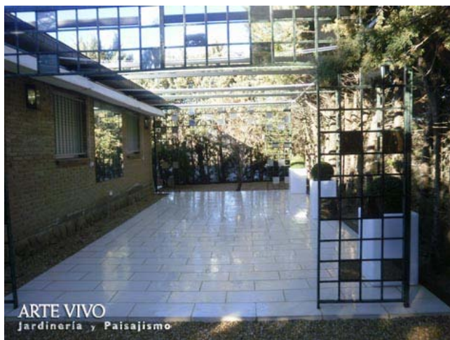
Pérgola con estructura de trillaje de pletina metálica formando cuadrícula con espejos y toldo de lona acrílica sobre zona de estar pavimentada con Gres porcelánico y decorada con jardineras de resina con sistema de autorriego y luz en Soto del Real.
