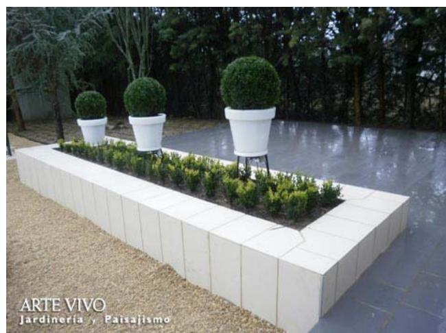
Detalle de banco-jardinera de obra chapado de Gres porcelánico color crema junto a plataforma solada de Gres porcelánico gris, con hidrojardineras de resina de polietileno con iluminación suspendidas sobre soportes metálicos escalonados. Soto del Real, Madrid.
