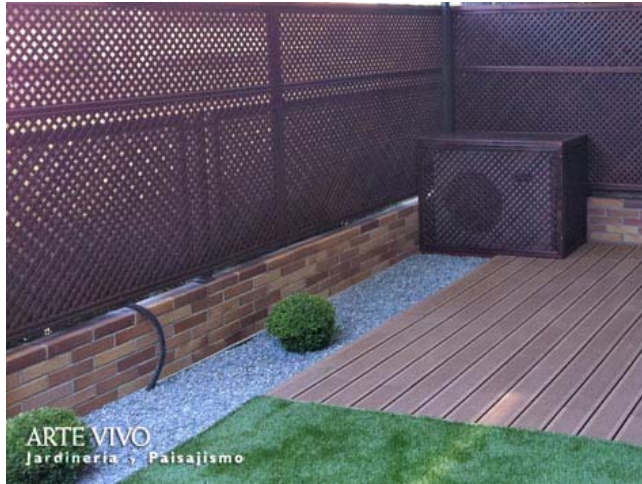
Celosía romboidal de madera tratada con lamas superpuestas en cerramiento perimetral de jardín y ocultación de unidad exterior de aire acondicionado. Las Rozas de Madrid.
