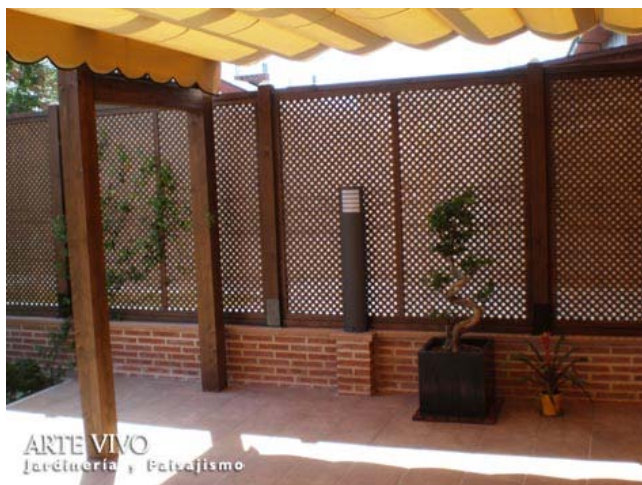
Detalle de bastidores con Celosías de Madera tratada entre postes anclados con cazoleta a muro existente en porche bajo Pérgola recta adosada con toldo de lona acrílica y aplicación de lasur protector en Getafe, Madrid.
