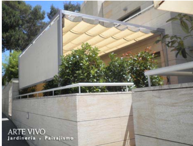
Pérgola metálica con toldo superior y toldo plano vertical de lona acrílica, sobre terraza anexa a entrada principal de vivienda en El Plantío, Madrid
