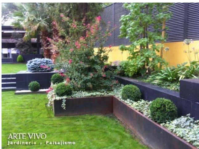
Chapa de Acero corten con pliegue superior y jardineras de obra revestidas de gres porcelánico negro a distintos niveles en lateral de jardín con césped en tepes y zonas con gravilla blanca definidas con fleje metálico. Boadilla del Monte, Madrid.
