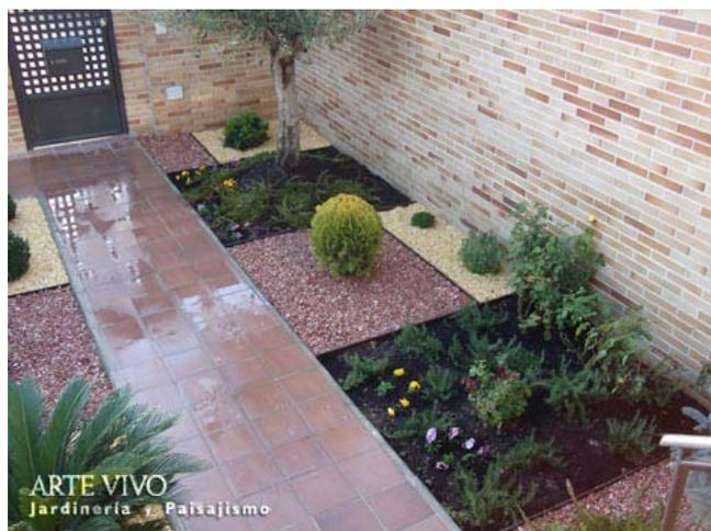
Jardín de entrada principal a vivienda con bordes rectos de fleje metálico separando plantaciones y gravillas roja y rosa a ambos lados de paso pavimentado con gres. Torrejón de Ardoz.
