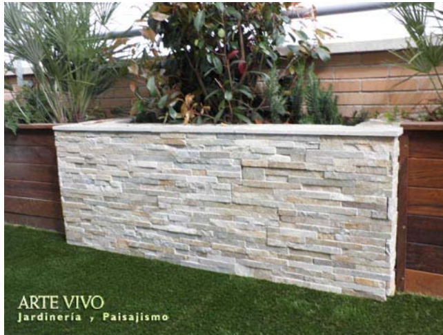
Chapado de jardinera central con Piedra premontada aligerada Cuarcita oro entre jardineras de Madera tropical en terraza de ático con césped ecológico. Villa de Vallecas, Madrid.
