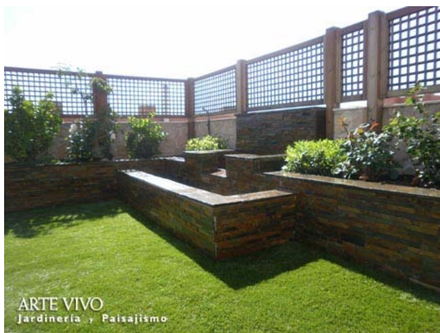
Estanque y jardineras de obra chapados de Piedra premontada aligerada Pizarra multicolor en terraza de ático con césped artificial en Carabanchel, Madrid.
