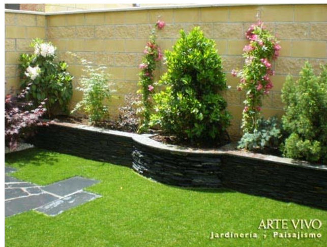
Jardineras de obra chapadas con Piedra premontada Laja Pizarra negra y cubremuros de Pizarra multicolor con detalle de jardinera central semicircular revestida de lajas de Pizarra negra. Torrejón de Ardoz, Madrid.
