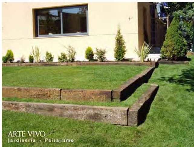
La creación de este bancales permite tener dos niveles en esta zona del jardín: uno a la altura del solado y otro inferior al de la piscina, sin necesidad de construir un muro. Encinar de los Reyes, Madrid.
