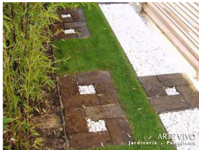
Detalle de Traviesas de ferrocarril como pavimento combinado con bolo blanco, pletina de acero y césped en jardín de adosado en Aravaca, Madrid.
