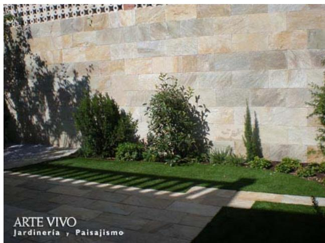
Muro frontal revestido con piedra natural Cuarcita dorada regular con plantación sobre tierra y gravillas en su base. Perales del Río, Getafe.
