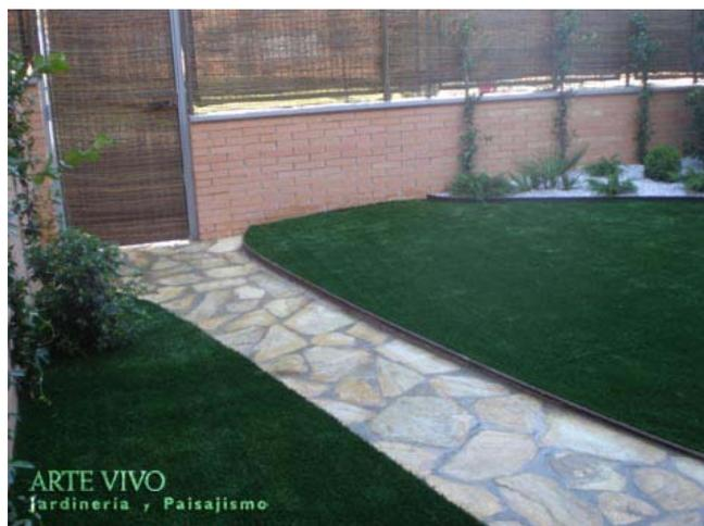
Camino de acceso a puerta trasera formado por lajas de Cuarcita blanca irregular con mortero de cemento en jardín con césped artificial, fleje metálico y plantación en gravillas. Arroyomolinos, Madrid.
