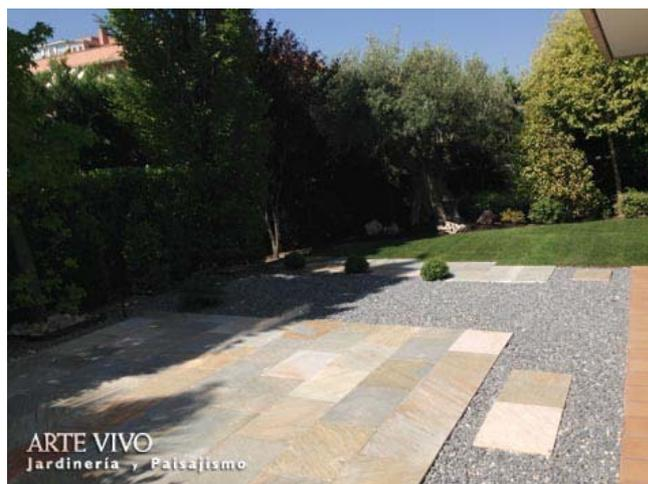
Pavimento y paso solado con forma escalonada de baldosas de piedra regular Cuarcita dorada entre gravilla gris y césped en tepes en jardín de entrada de Pozuelo de Alarcón.
