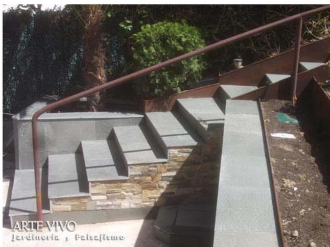
Muro y jardinera de obra con chapados y cubremuros de piedra Cuarcita gris a ambos lados de escalera revestida del mismo material con lateral chapado de piedra resinada aligerada. El Soto de la Moraleja, Alcobendas.
