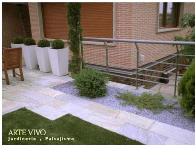
Separación entre césped sintético y plantación sobre gravilla gris, con baldosas de Cuarcita regular fijadas con mortero de cemento especial para piedra natural. Las Rozas de Madrid.
