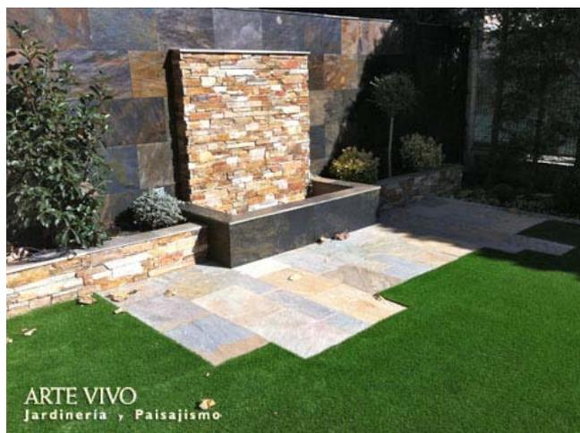
Detalle de pavimento de Cuarcita dorada regular bajo estanque de obra entre jardineras con mural-cascada revestido de piedra premontada Cuarcita y vaso con chapado y cubremuros de pizarra multicolor rústica en Rivas Vaciamadrid.
