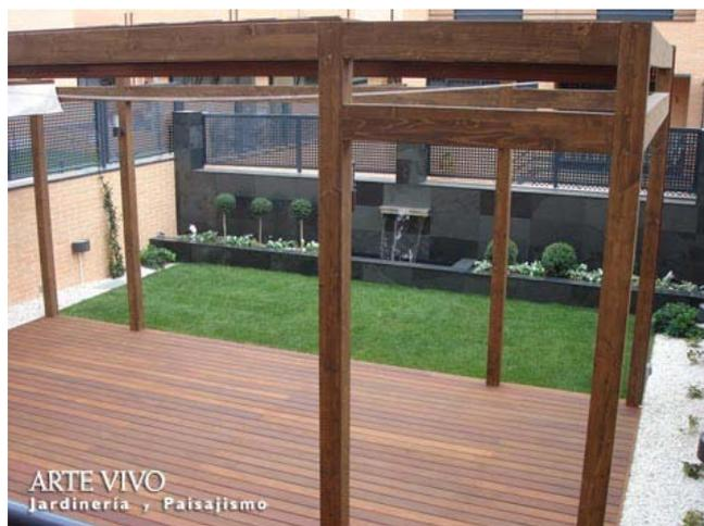
Pérgola de Madera laminada exenta con 8 pilares y doble viga superior formando marco y travesaños de la misma sección, sobre tarima de Madera de ipé junto a césped en tepes y plantaciones sobre gravillas. Valdemoro, Madrid.
