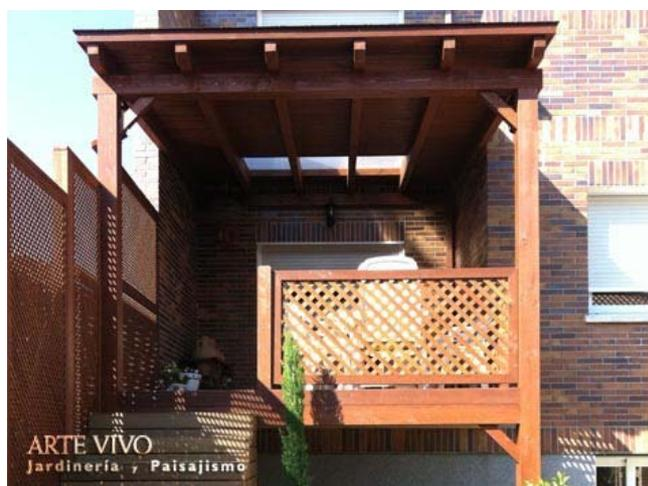
Deck elevado de Madera laminada en terraza con cubierta a un agua sobre travesaños, pilares y vigas de carga con jабalcones y cerramiento lateral y de barandilla romboidal en Villaviciosa de Odón, Madrid.
