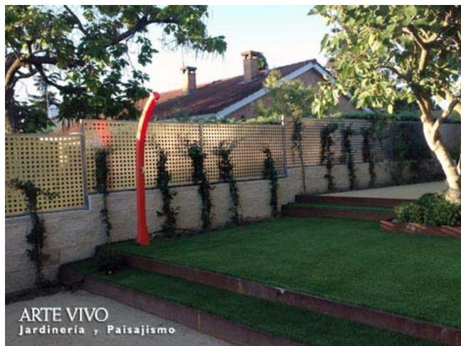
Ducha exterior sobre césped artificial y pavimentos de jable a distintos niveles en jardín con peldañado de chapa de acero corten y cerramiento lateral de chapa perforada sobre muro escalonado de bloques de hormigón. Pozuelo de Alarcón.
