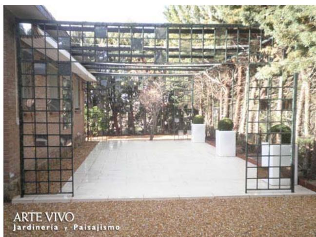
Pérgola con estructura de trillaje de pletina metálica formando cuadrícula con espejos sobre zona de estar solada con gres porcelánico y decorada con hidrojardineras de resina PE con iluminación entre pavimentos de piedra triturada color marrón claro. Soto del Real, Madrid.
