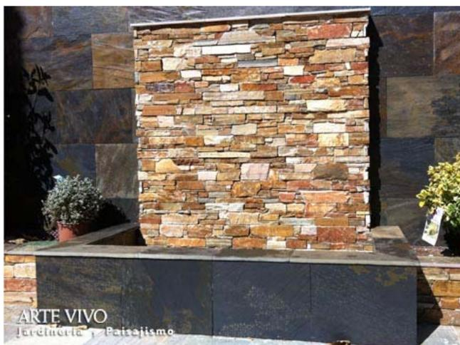
Detalle de mural-cascada con Piedra Premontada cuarcita sobre estanque de obra con chapado y cubremuros de pizarra multicolor adosado a pared revestida con el mismo material en Rivas Vaciamadrid.
