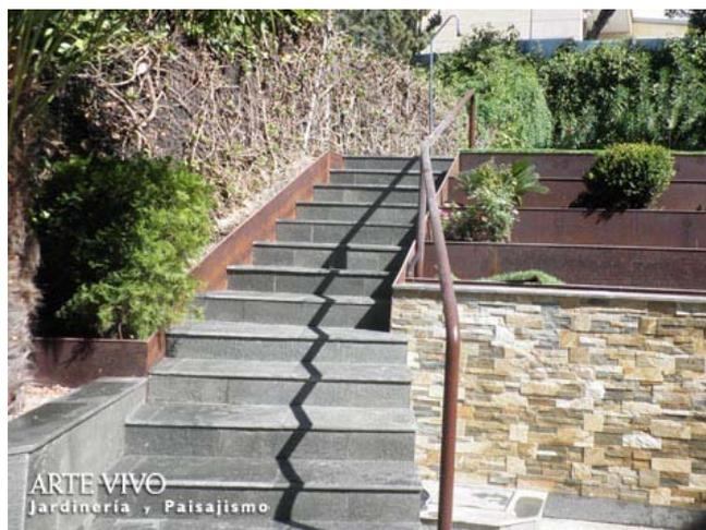
Escalera de acceso a piscina particular revestida con cuarcita gris regular y flanqueada con chapa de acero corten con muro lateral chapado de Piedra Premontada resinada. Alcobendas, Madrid.
