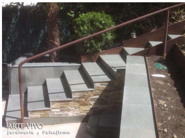
Muro y jardinera de obra con chapados y cubremuros de piedra cuarcita gris a ambos lados de escalera revestida del mismo material con lateral chapado de Piedra Premontada resinada. El Soto de la Moraleja, Alcobendas.
